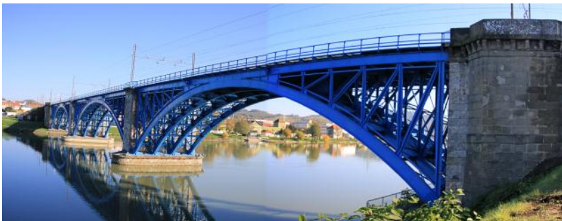
Mariborski železniški most je bil v jekleni izvedbi zgrajen leta 1866, ko so zgradili novo progo iz Maribora po Dravski dolini. Obnovljen je bil 2016 in je razglašen za spomenik tehniške dediščine. (foto Andrej Ivanuša)
